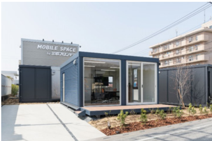
ブルーの外壁にホワイトのサッシを組み合わせた外観です。
