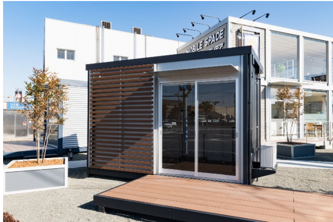
38MSL オフィススペース 外観
